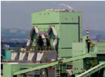
亚太森博山东工厂生物质能源发电项目
