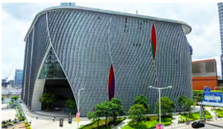
香港戏曲中心玻璃幕墙项目
