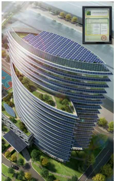
水发兴业新能源产业园研发楼
