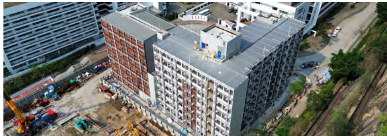
香港观塘区彩兴路过渡性房屋项目
